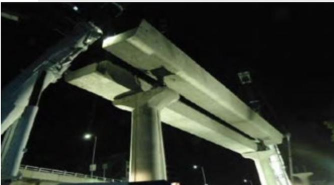
CÓNEXIÓN COLUMNA-TRABE CAJÓN SECCIONADA
