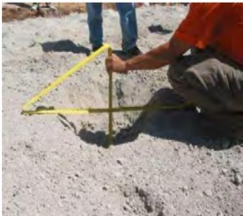
Control de espesores, humedad y homogeneidad del mezclado.
