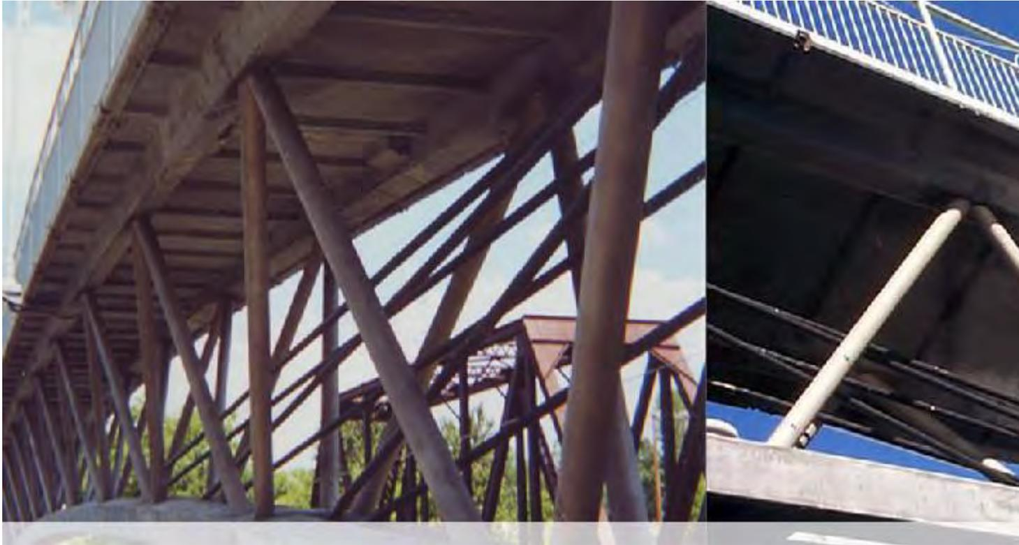
Puente Sheerbrooke – Canada : UHPC en las diagonales y tablero 30 mm - 1997
