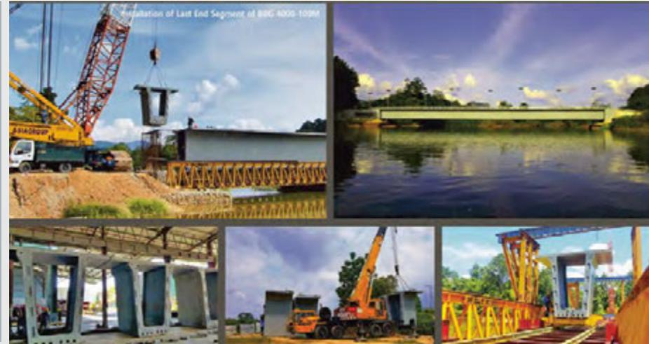
**VIGAS TIPO CAJÓN RANGO ENTRE 80 Y 100m**
