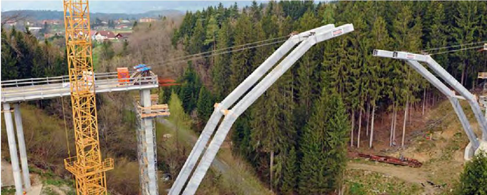
*Puente, Volkemort , Austria : Arcos prefabricados UHPC 60 mm 2011*
