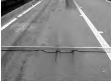
Figura 1. Fenómeno del ahuellamiento. Vía Calle 80, Bogotá, Colombia.
