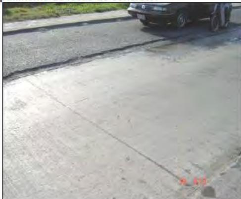
Figura 16. Escalonamiento de Juntas
