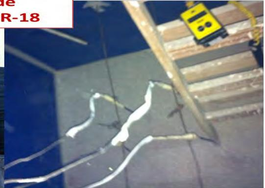
**Colocación, armado y calibración del registrador de temperatura.**
