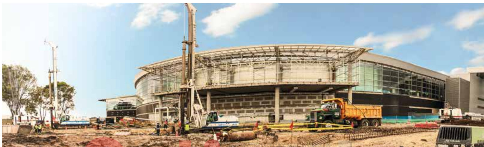
↑ Fase I de la ampliación de la terminal de pasajeros del Aeropuerto Internacional el Dorado – Construcción de Pilotes – Bogotá D.C.
