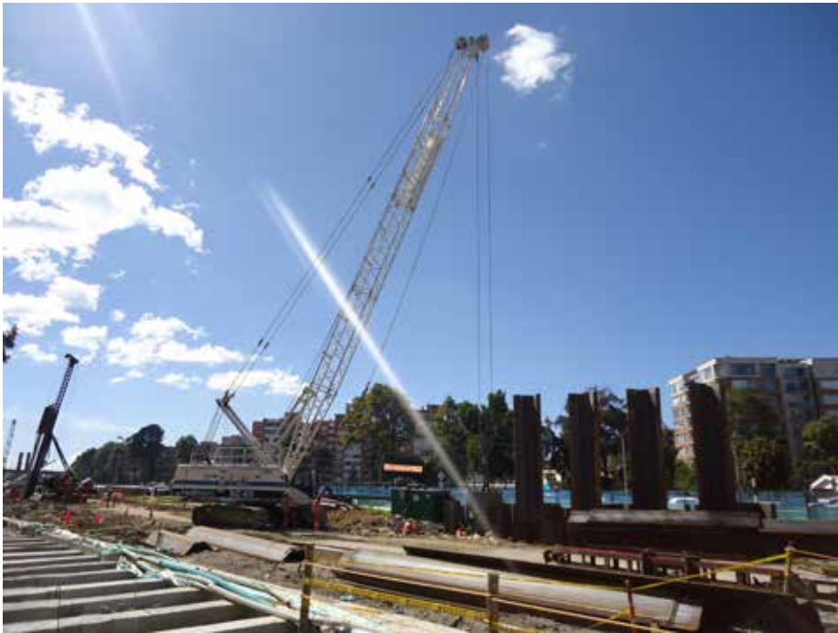
◀ Intersección a desnivel Calle 94 – Instalación de tablestacas metálicas y pilotes metálicos – Bogotá D.C. CORTESÍA DE ROBERTO GALANTE
