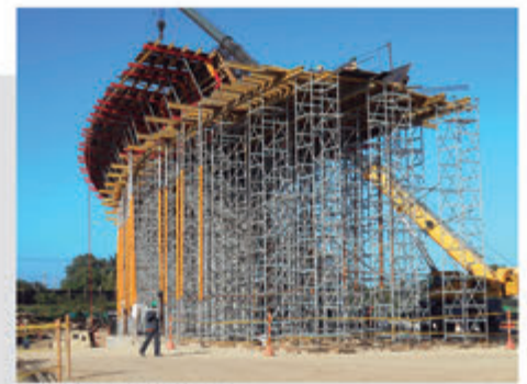
Nuevo Puente Pumarejo (Barranquilla - Atlántico) Sistemas Empleados: TRIO, ST-100, LIWA, CB-240, MULTIFLEX, PERI UP.
