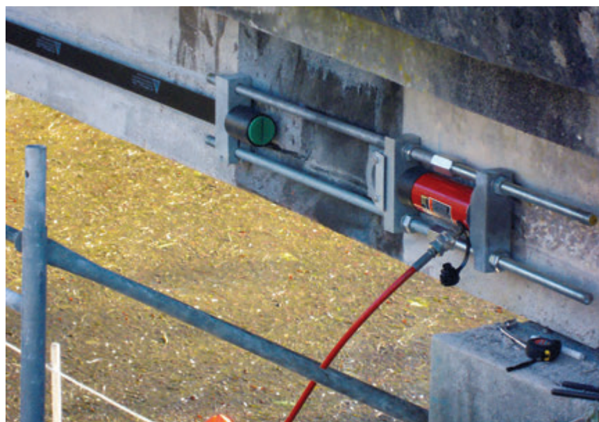
↑ Foto 7. Tensionamiento de una platina de carbono en el reforzamiento de un puente en Francia. Se distinguen la cabeza de fibra de carbono en el extremo de la platina de carbono, los anclajes metálicos (extremo móvil o extremo de tensionamiento) y el gato hidráulico que aplica una fuerza de 22 ton.
