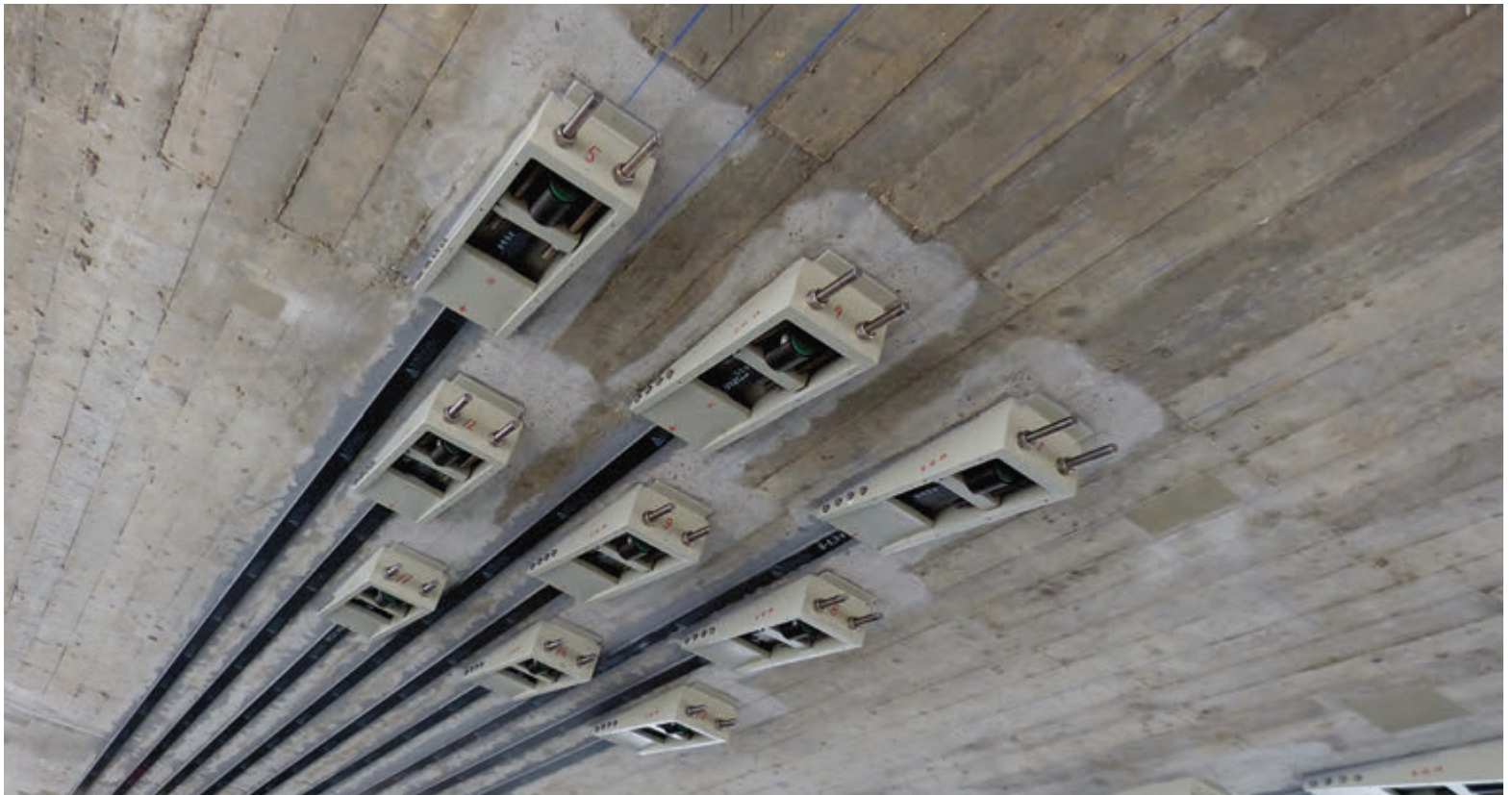
↑ Foto 5. Extremo móvil del sistema de platinas de carbono postensadas (zona donde se coloca el gato hidráulico para la aplicación de la fuerza de tensado), en un puente en Suiza.
