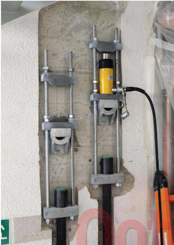
↑ Foto 3. Extremo móvil del sistema de platinas de carbono postensadas.
