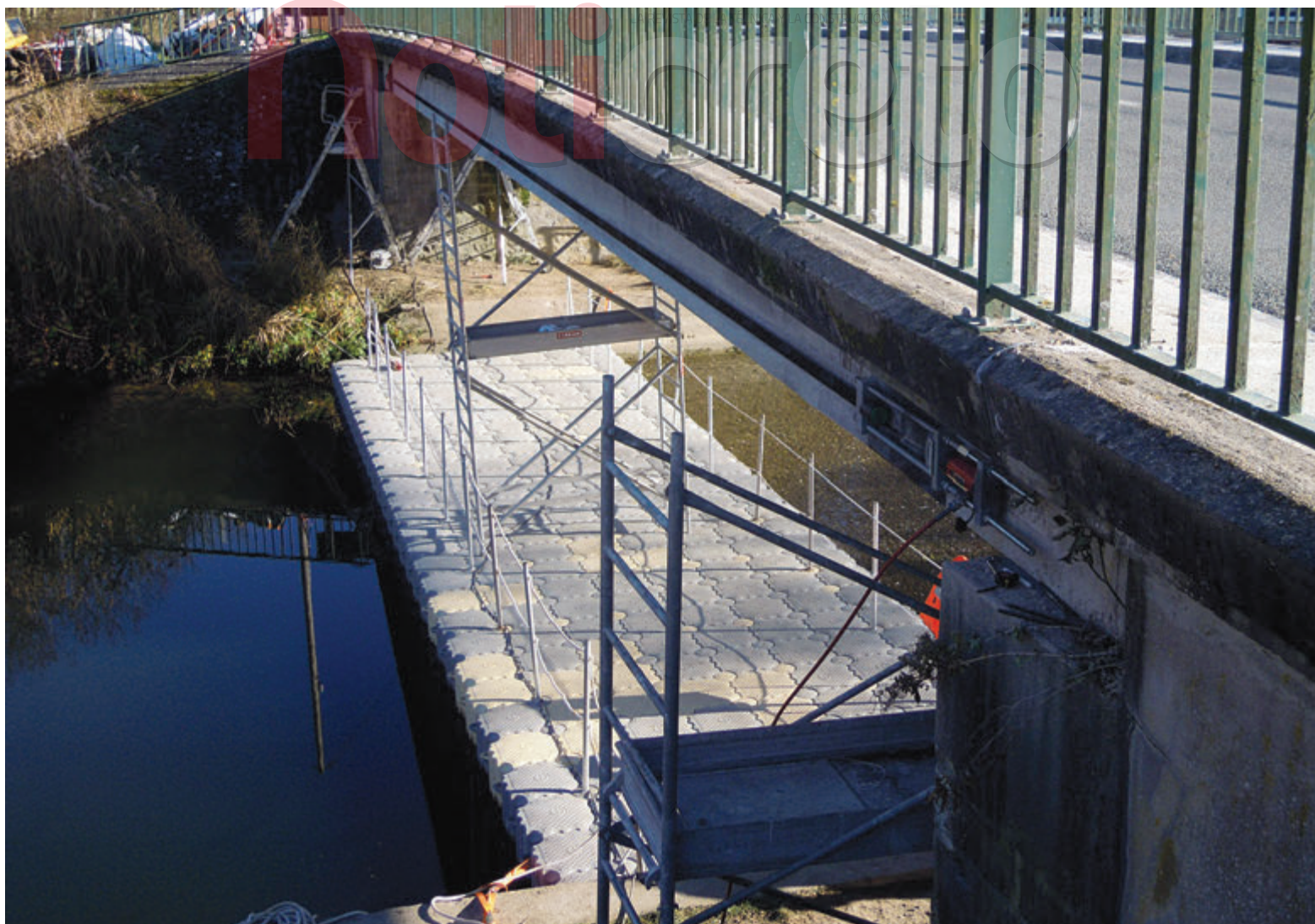
↑ Vista lateral de un puente en Francia reforzado con las platinas de carbono tensionadas (parte lateral de las vigas).
