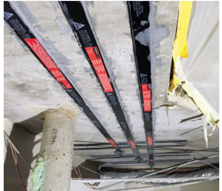
↑ Foto 4. Platinas de carbono postensadas en la losa de un edificio en Viena (Austria).
