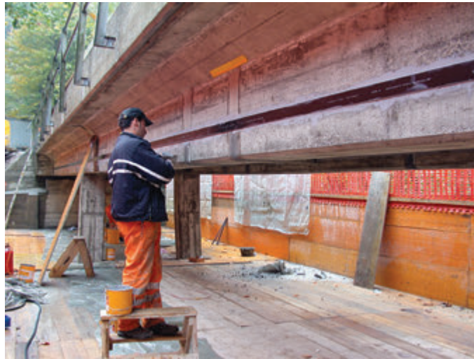
➔ Foto 8. Platina de carbono en la parte lateral de una viga de un puente en Suiza.
