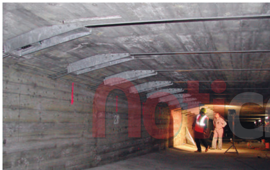
↑ Foto 6. Interior de la viga cajón de un puente en Suiza. Se ven las platinas de carbono y el extremo móvil (zona donde se hace el tensionamiento de las platinas de carbono).
