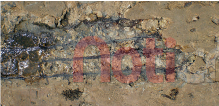
↑ Pérdida de recubrimiento y exposición de barras de refuerzo. CORTESÍA UNIVERSIDAD DEL NORTE
