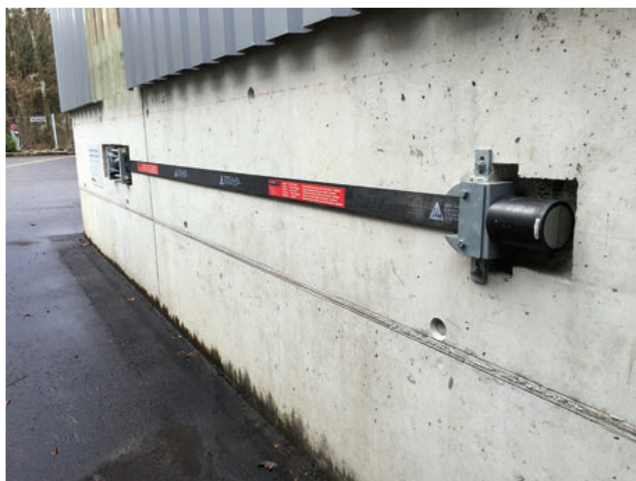
↓ Figura 1. Esquema de una estructura reforzada con una platina de carbono postensada.
