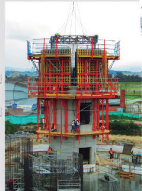
Fuste Torre de Control - Aeropuerto El Dorado (Bogotá) Sistemas Empleados: VARIO VT-20K, RCS-LITE.
