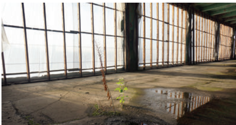
↑ New York Dock. Obsérvense las finas láminas de poliestireno resistentes a la intemperie, el agua estancada y la formación de crecimiento de plantas en losa saturada.
