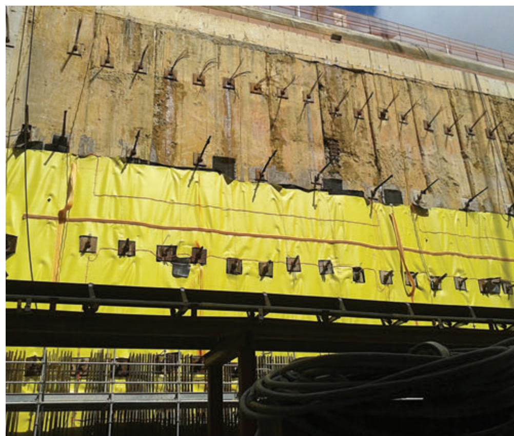
↑ Construcción de la ampliación de la línea 5 del Metro de Sao Paulo, donde se observa la impermeabilización con membranas de PVC-P.
