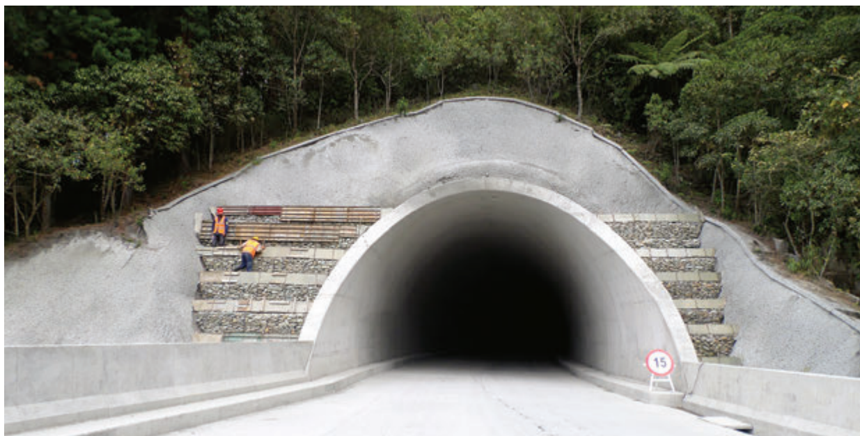
➔ Obras anexas del túnel de La Línea. ARCHIVO INVIAS
