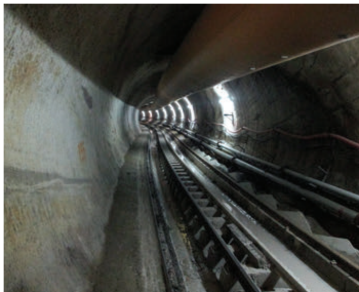
↑ Vista del túnel terminado, revestido con concreto.
