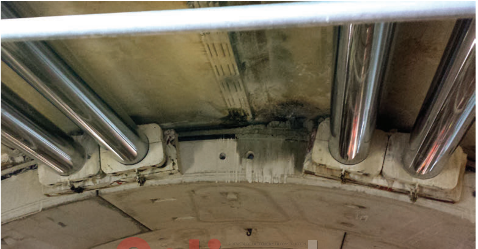
Figura 3. Grout que superó las cuchillas de aislamiento del TBM.
