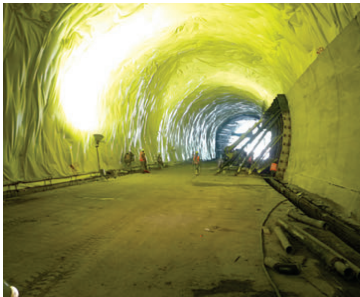
↑ Impermeabilización túnel vial Hidrosogamoso. CORTESÍA SIKA COLOMBIA S.A.
