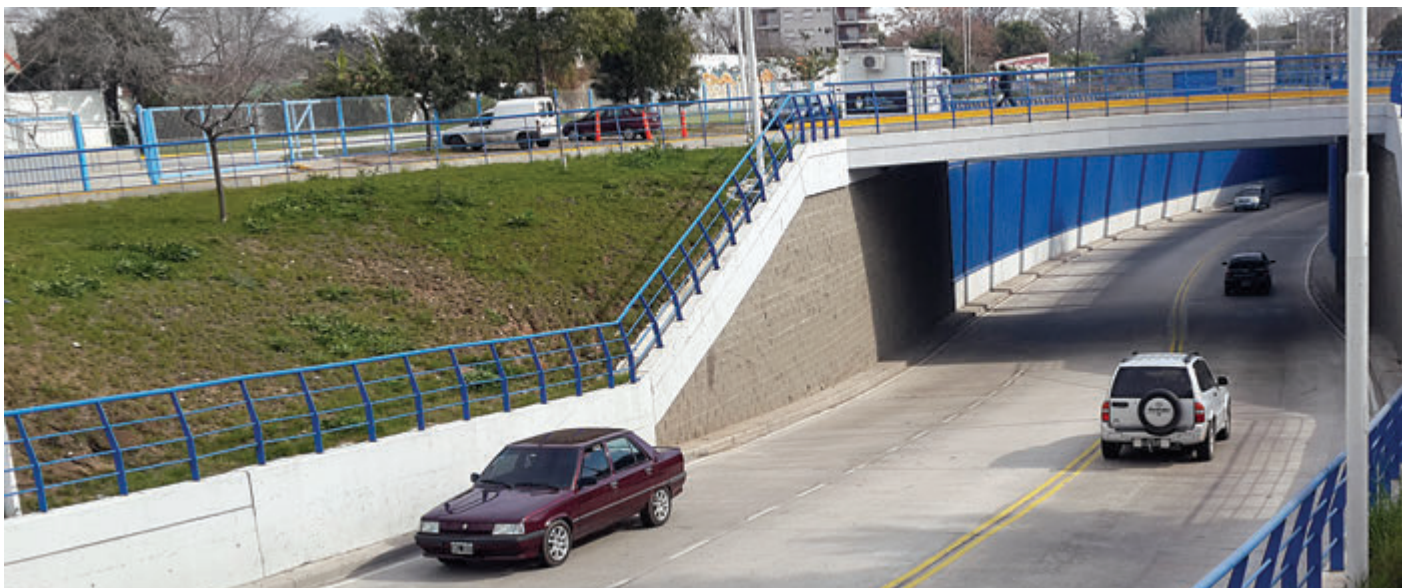
↑ Paso bajo nivel construido por debajo de las líneas ferroviarias, cuya impermeabilización se realizó con membranas flexibles de PVC. CORTESIA SIKA COLOMBIA S.A.
