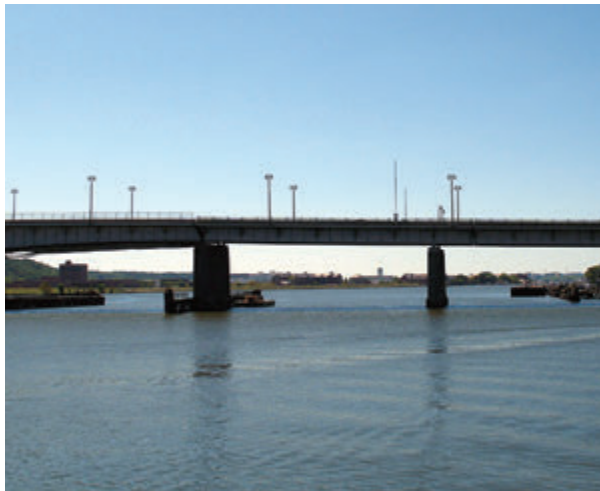
↑ El puente sobre el río Anacostia, de 2.330,2 m y conformado por 55 vanos, fue construido en parte sobre terraplén y otra como estructura aérea.
