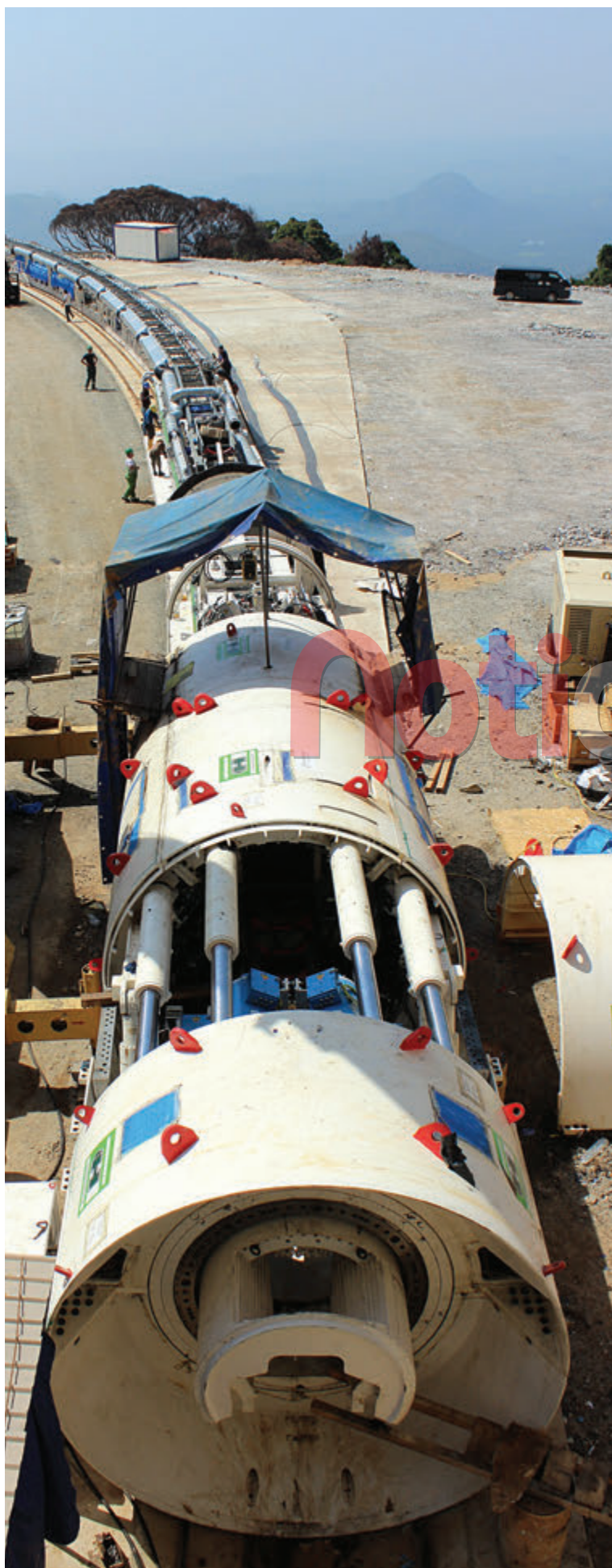
↑ Montaje del doble escudo TBM en obra.
