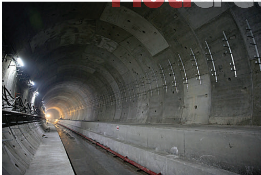
↑ Las obras del proyecto de la nueva línea del metro comenzaron en octubre de 2012 y se estima que tenga una duración de 68 meses.
